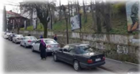
253- Eski Öğretmen Evi Karşısı Duvar Giydirme İşleri.
