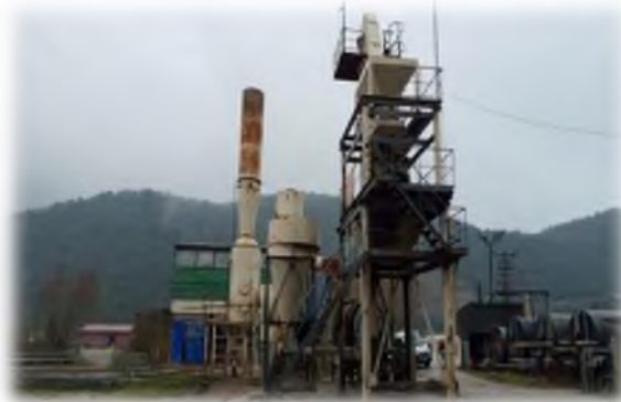
187- Asfalt Şantiyesi Bakım Onarım İşleri.
